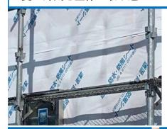
本来壁の中の水蒸気を外部に放出する役目なのですが、文字どおり「透湿」なので 夏外気に含まれる大量の水蒸気を取り込んでしまいます。水蒸気の性質は水蒸気圧の 高いほうから低いほうに移動します。冬は室内側の水蒸気圧が高く外部のほうが低い ので理にかなっていますが、夏は逆に外気の水蒸気圧が高く低い壁体内へ流れ込んで しまいます。その上最近はグラスウールやウレタンなど断熱材を充填させる工法が ほとんどで、壁体内は閉塞!通気は行われないためカビや腐朽菌の繁殖しやすい環境 となっています。
