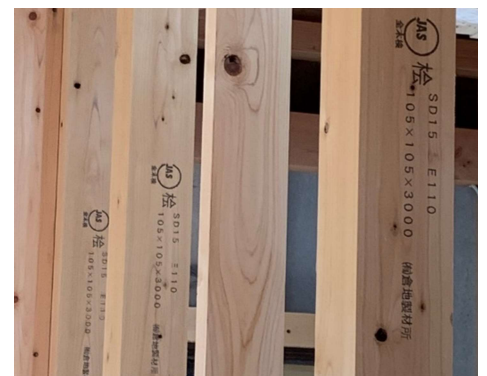
D1 特定樹種木曽川流域産「桧」 を使い通気を確保した アイディールの家の壁体（上） と根太組み床下空間（下）
