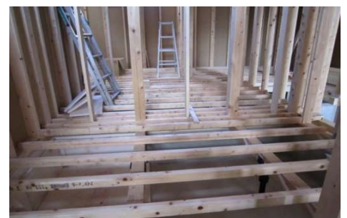
D1 特定樹種木曽川流域産「桧」 を使い通気を確保した アイディールの家の壁体（上） と根太組み床下空間（下）
